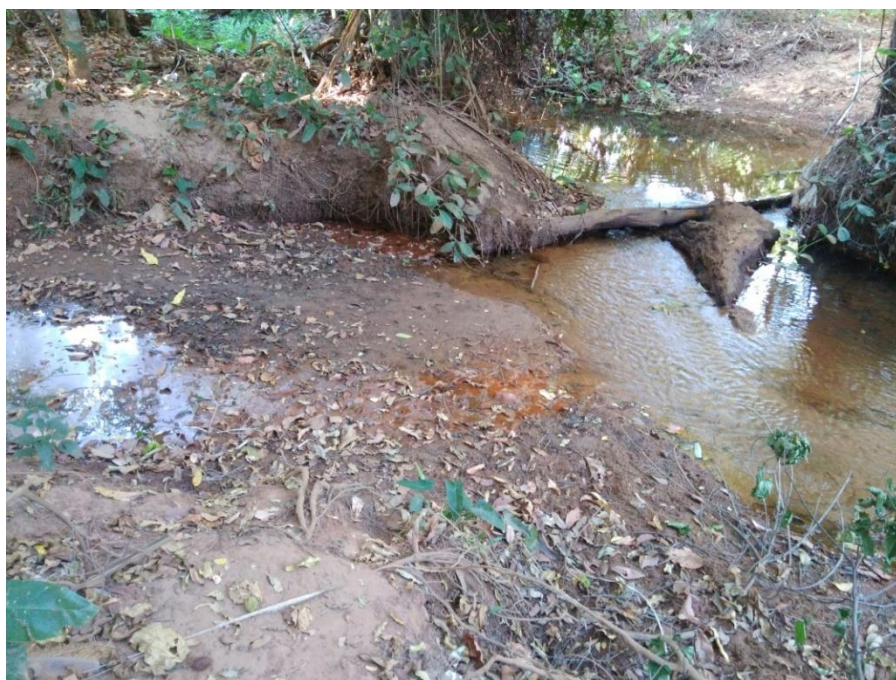
Figura 6. Assoreamento, área próxima à nascente, do Córrego Sussuapara, Palmas – TO.
