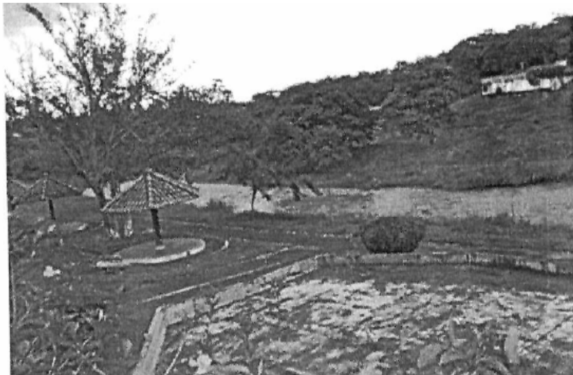
Figura 4 – Ausência de Mata Ciliar na APP e construções indevidas
